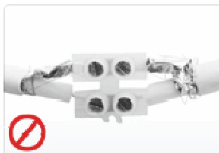
Kabler med forkerte eller dårlige samlinger
