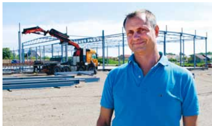
En af årets store opgaver for Morten C. Henriksen er opførelsen af Bin2Bils nye domicil ved Holbæk Mega Center.
