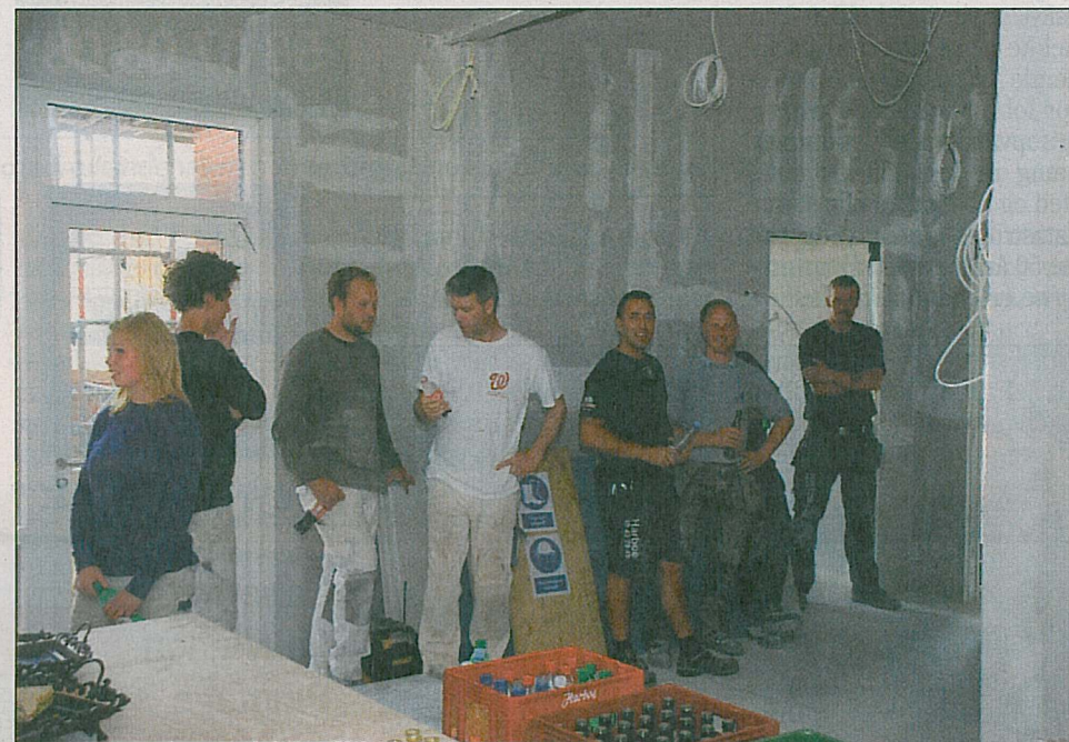
Håndværkerne slapper af for et øjeblik ved rejsegildet
